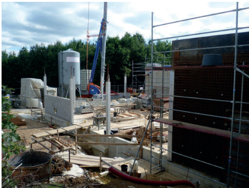
Das im Bau befindliche Wasserwerk „Wolfsbusch“
