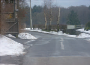
Im Mühlenweg in Schoppen wird ein Bürgersteig gebaut.
