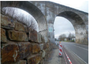
Die Arbeiten am Viadukt Born gehen im Frühjahr zu Ende.
