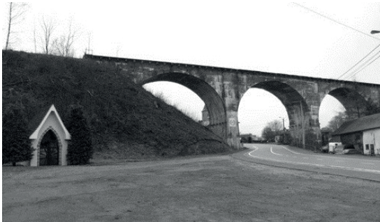
Auf der Brücke Born entsteht ein Aussichtspunkt mit einem wunderschönen Blick auf das Emmels- und Ameltal. Unter der Brücke wird ein Dorfplatz eingerichtet.
