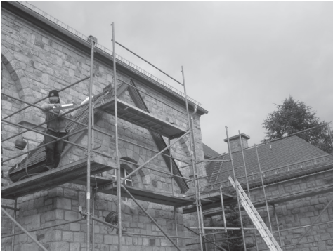
Foto: Die Kirche Born erhielt ein neues Dach. Zusätzlich hat der Arbeiterdienst der Gemeinde die Bruchsteinmauer neu ausgefügt.
