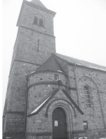
Die Kirche Born erhält ein neues Dach.
