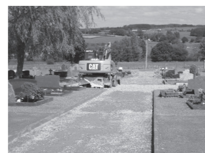
Die Arbeiten am Friedhof Deidenberg sind nunmehr beendet.
