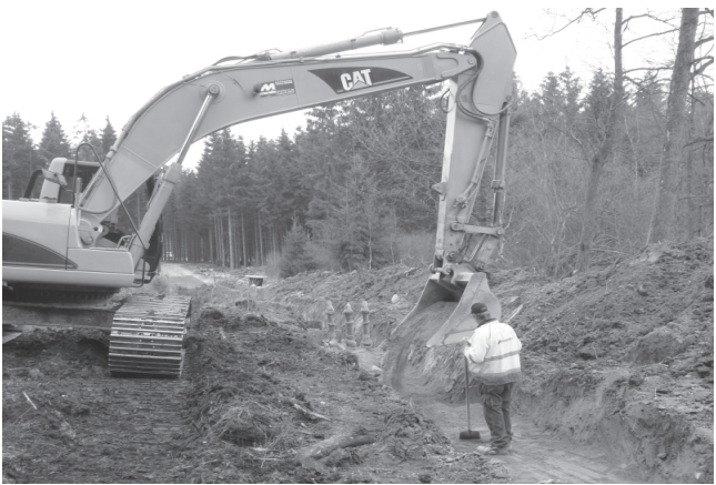
Foto: Im Wolfsbusch werden zur Zeit die Brunnen an das Wasserleitungsnetz angeschlossen.
