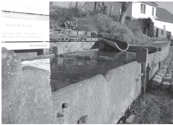
Foto: Die alte Blausteintränke im Ortszentrum von Amel wird wieder mit Wasser gespeist.
