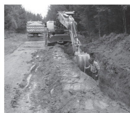
Die Arbeiten zur Erschließung der neuen Brunnen im Wolfsbusch sind angelaufen.
