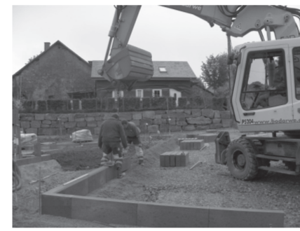
Die Arbeiten zur Gestaltung eines Dorfplatzes in Schoppen gehen voraussichtlich im November 2010 zu Ende. Das Unternehmen Bodarwé/Malmedy hat für dieses Projekt den Zuschlag erhalten. Die Kosten in Höhe von 325.000 € übernehmen die Gemeinde Amel (20 %) und die Wallonische Region (80 %).
