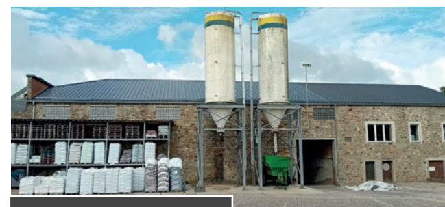
Saniertes Dach alte Molkerei Amel
